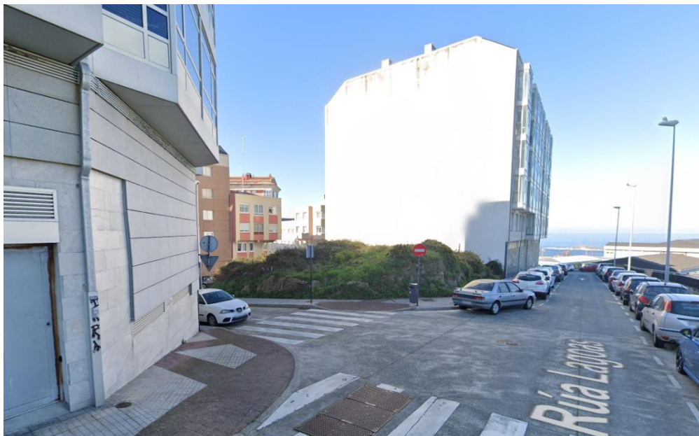
Imagen de la medianera vista.
