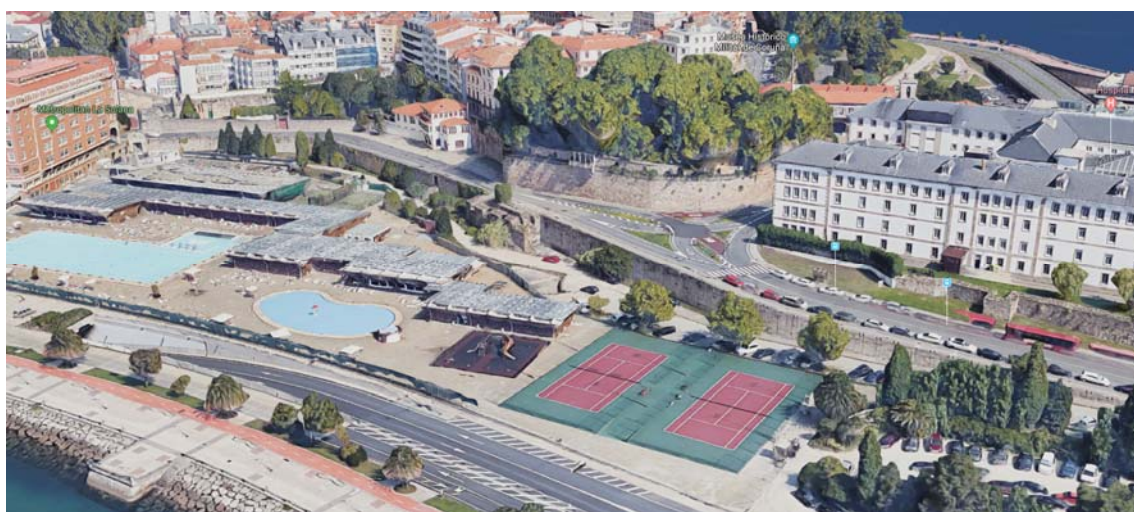
Paseo del Parrote, tramo Hotel Finisterre – Muelle de Ánimas, en el que se puede apreciar el punto de contacto con la explanada del puerto, en este último.
