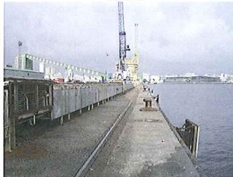
Detalle del cantil del Muelle del Centenario Norte, con el sistema de cintas para graneles a la izquierda
