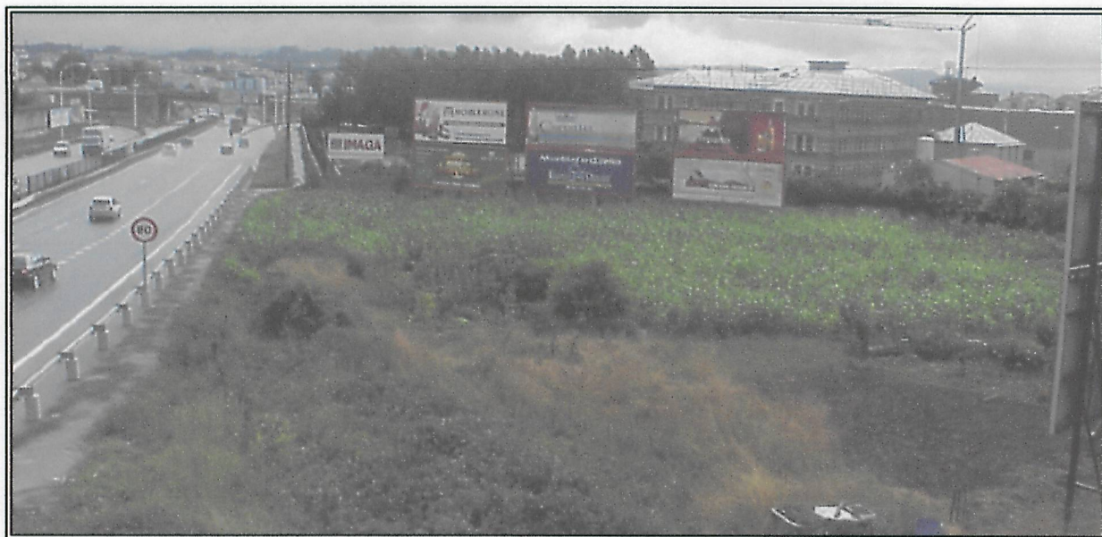
4 VISTA GENERAL DESDE LA PASARELA PEATONAL
